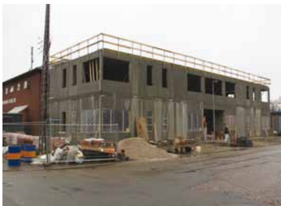
Den nye tilbygning begynder at tage form.
